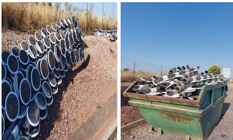
Parrillas viejas extraídas y cargadas en contenedor para envío a vertedero
