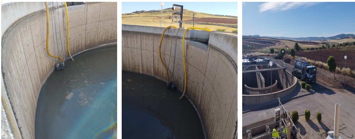
Bombas sumergibles para vaciado del agua sobrenadante y camión succionado fango
