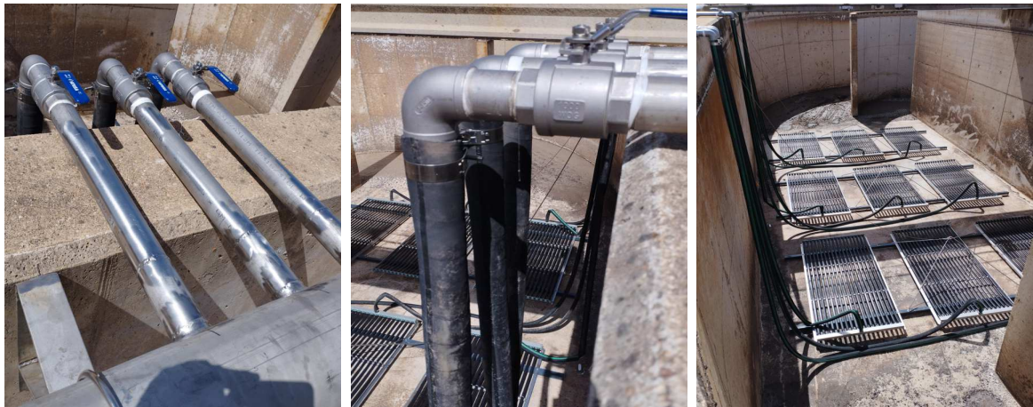
Colector y conexiones de éste a los módulos de aireación mediante manguera flexible
